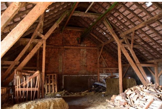
Abbildung 13: Haus Nr. 7 Innenansicht Dachboden mit Heulager
