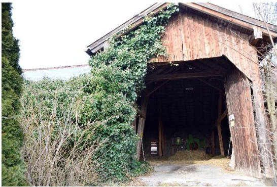
Abbildung 11: Haus Nr. 7 Ansicht von Ost, mit Efeu bewachsener Eingangsbereich zum Heulager
