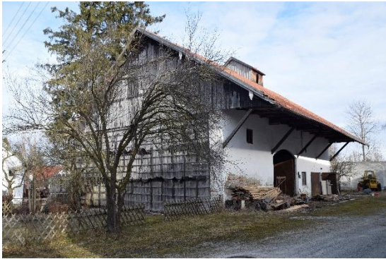
Abbildung 3: Hausnummer 5, Ansicht von Südost
