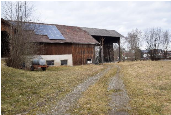
Abbildung 15: Haus Nr. 7 ehemaliger Kuhstall und Futtersilo
