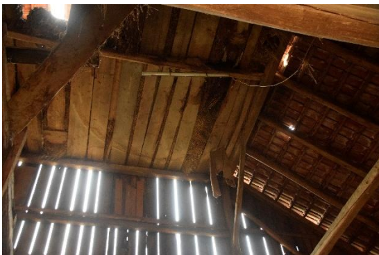
Abbildung 5: Haus Nr. 5, Innenansicht von Dach und Dachboden.
