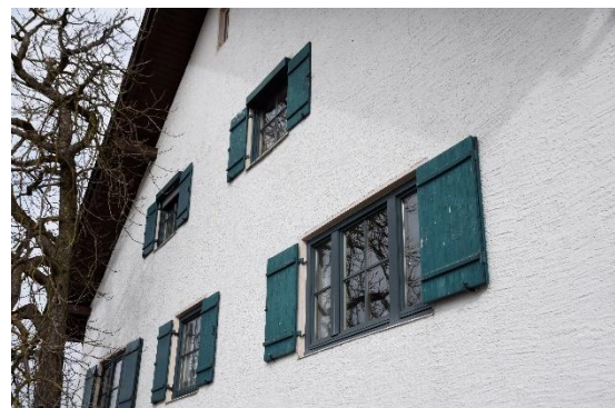
Abbildung 10: Haus Nr. 7 mit ehemaligem Wohngebäude und Kastanie
