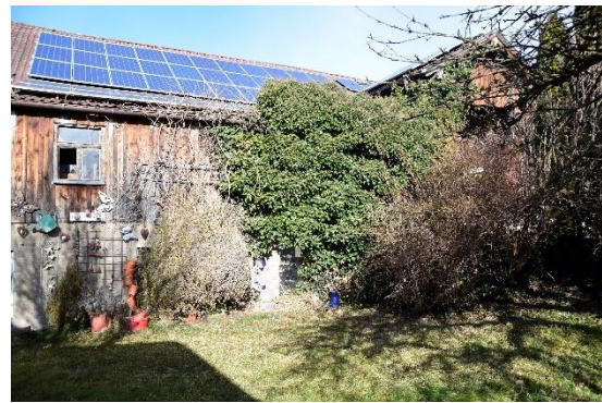
Abbildung 12: Haus Nr. 7 Ansicht von Ost, mit Efeu bewachsener Eingangsbereich zum Heulager
